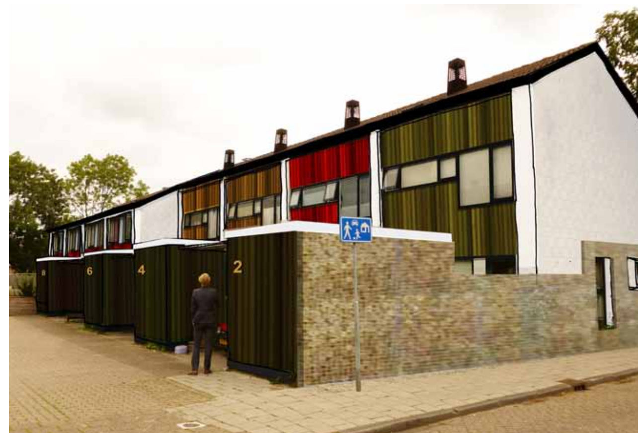
De nieuwe kopgevel verbindt alle elementen (berging, schutting, woning, tuin) door een plint van schanskorven ervoor te plaatsen. Een rustige uitstraling van het gehele blok aan de wijkontsluitingsweg tot gevolg.
