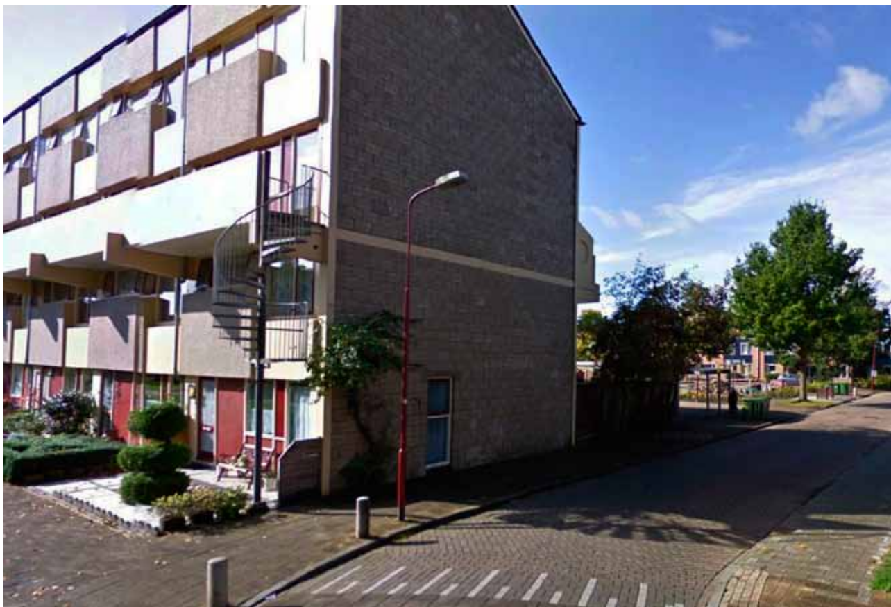
Vluchttrap in de huidige situatie stopt op de 1e verdieping en is vormgegeven als een toegevoegd losstaand element.
