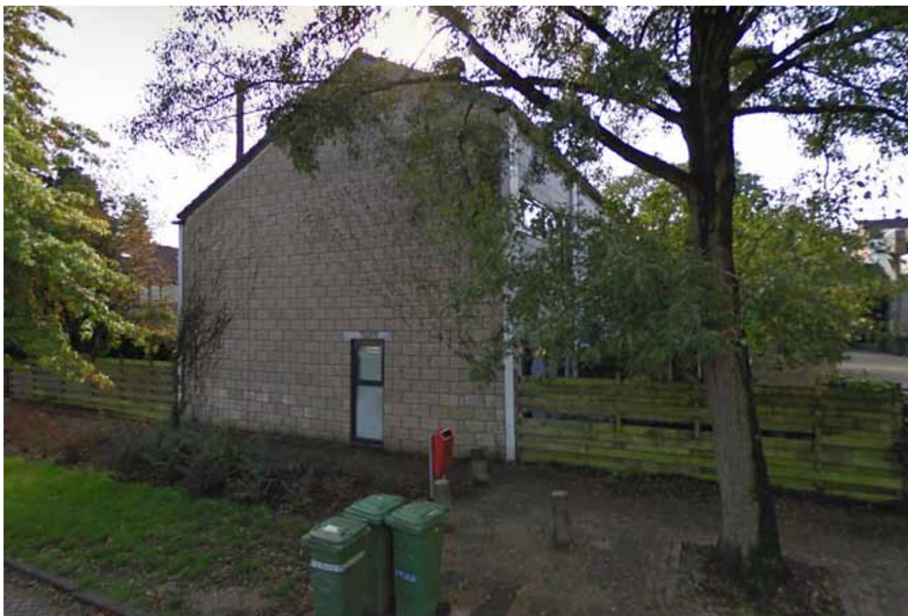
Nu en dan zit er wel een raam in de kopgevels, maar de situatie nodigt niet uit tot interactie.
