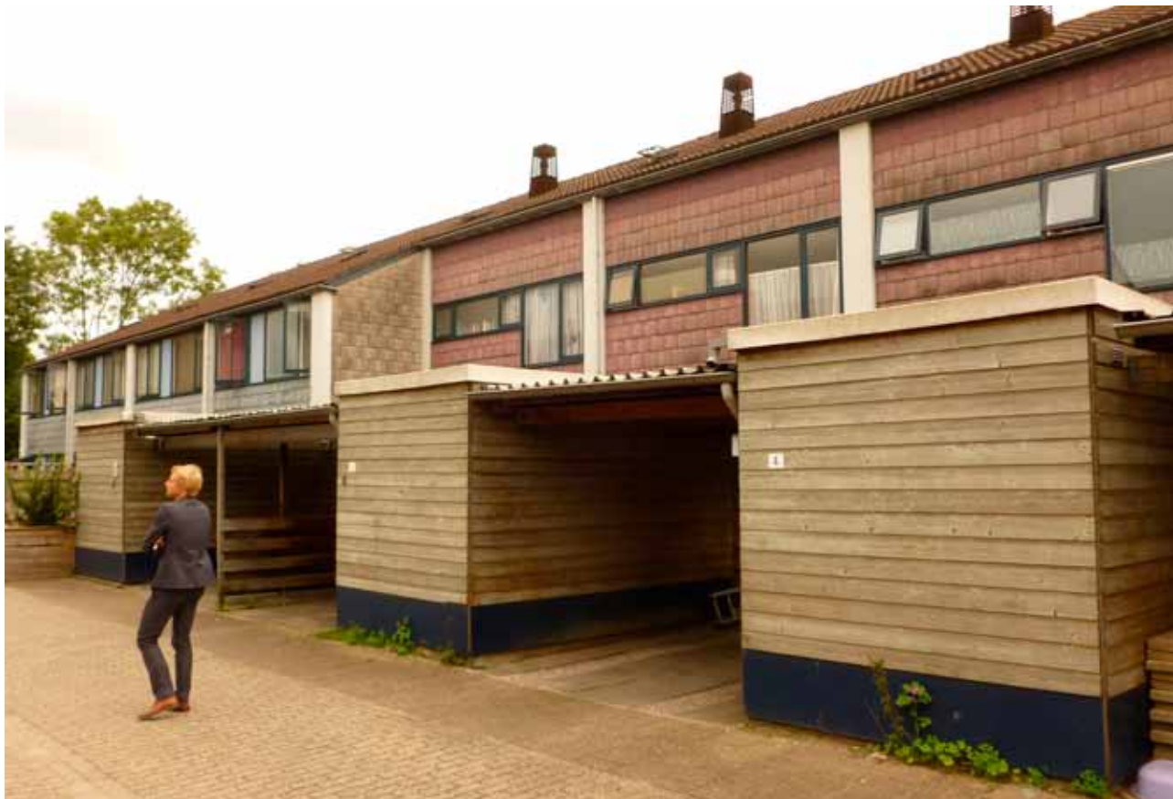
De bergingen aan de voorzijde spelen een belangrijke rol in de grijze uitstraling van de wijk. De gevelbekleding van de woningen met asbesthoudende singels draagt tevens bij aan een grijs en vervuild straatbeeld.
