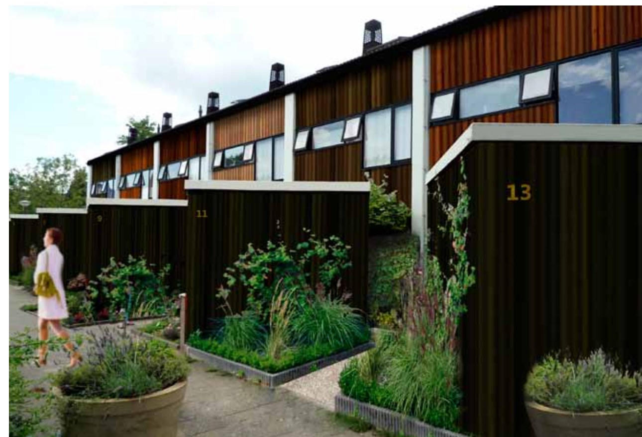
De gevels worden aangepakt en de overgangen worden met plantenbakken gemaakt.
